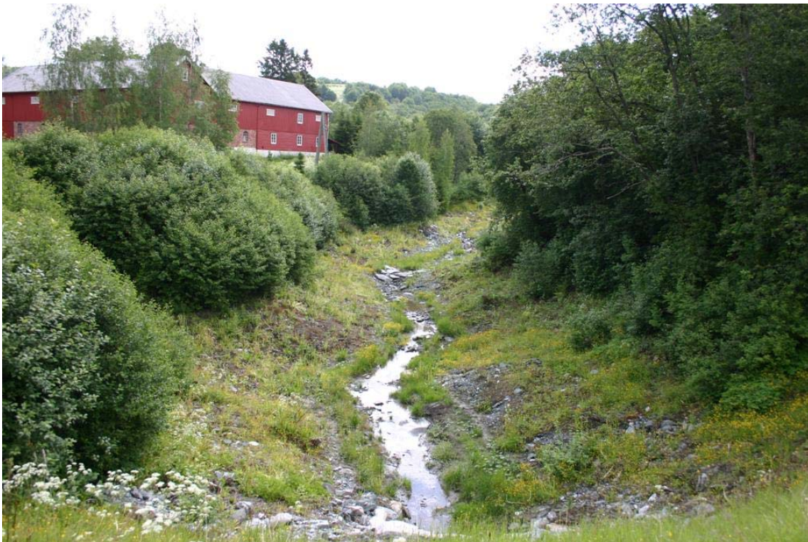
Bilde 4: Miljøtilpasset steinfylling. Valsetbekken i Skaun kommune 1 år etter lagt fylling
