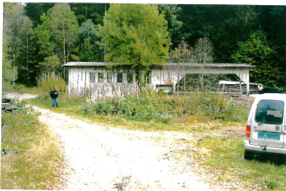
Lokalitet for bygging av kraftverk.
