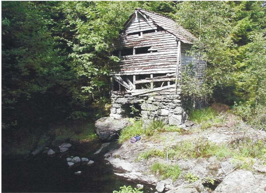
Den gamle kraftstasjonen i Lauvik frå 1016
