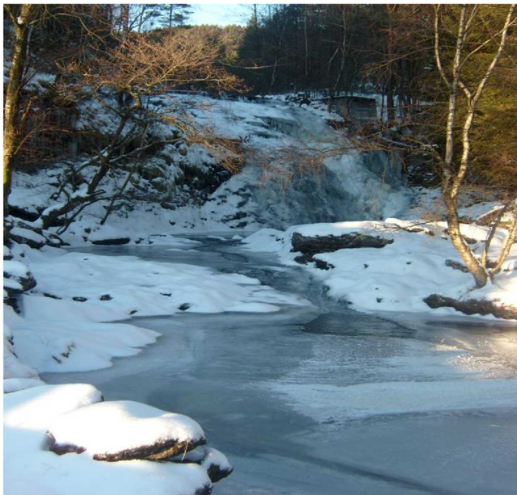
Fossen ved den gamle inntaksdammen frå 1916
