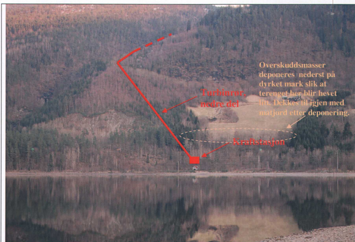
Bildet er tatt fra sydsiden av Vangsvatnet mot sydøst og viser området ved planlagt kraftstasjon. Kraftstasjonen er planlagt rett over eksisterende nøst. Bildet viser område for deponering av overskuddsmasser.
