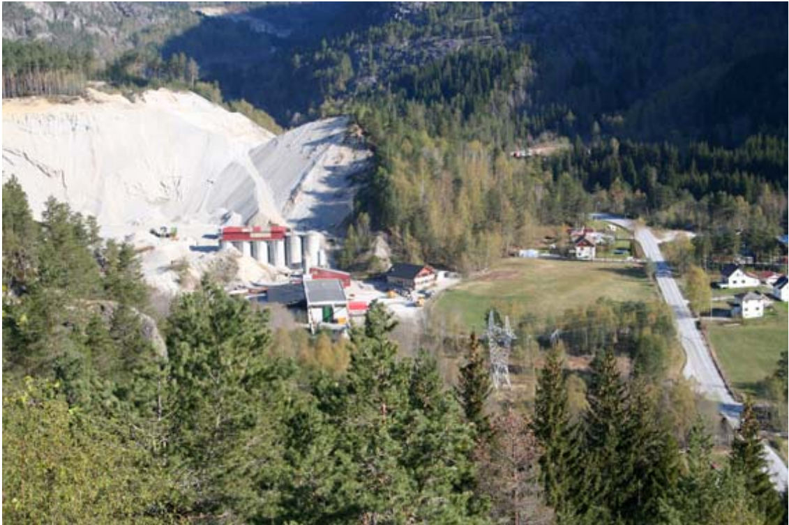
Figur 1: Oversiktsbilete av Skarpamoen. Stasjonen er planlagt plassert mellom kraftlinjene i forkant av industriområdet.
