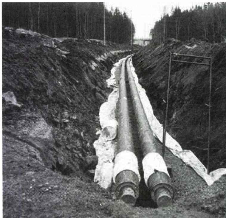
Bygging av fjernvarmeanlegg er krevende og forutsetter store og langsiktige investeringer. Energi basert på avfall og biomasse vil være en viktig del av energiomleggingen i Norge i årene fremover. Bildet er fra varmeanlegget ved Halden fengsel.
