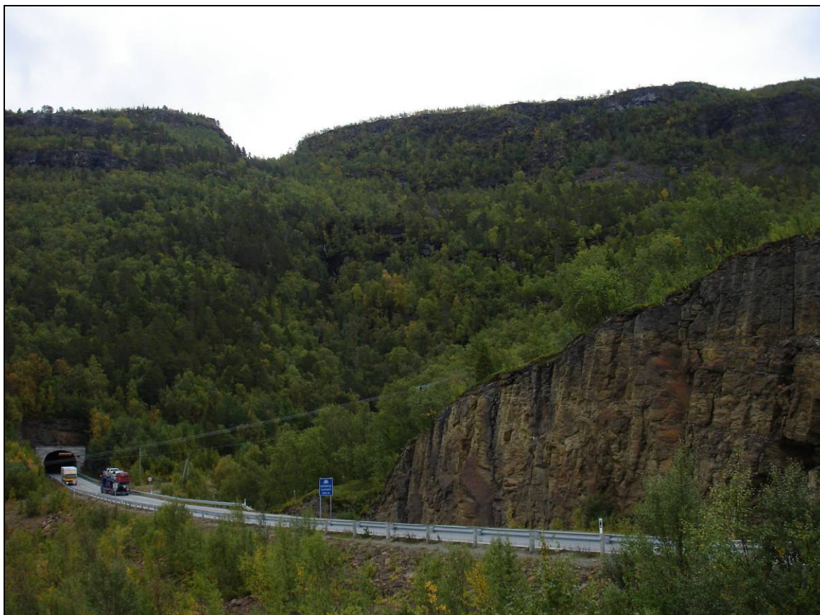
Figur 3 E6 med Larsbertunnelen. Larsbergelvene kommer ned i søkket til høyre for E6 og føres ut til sjøen gjennom veifyllingen.
