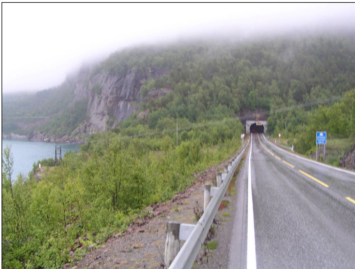
Figur 4 E6 mot Larsbertunnelen. Larsbergelva kommer ut fra veifyllingen like ved 22 kV høyspent endemast/sjøkabel. Høyspentline går sydover over høydedraget mot Skibotn.
