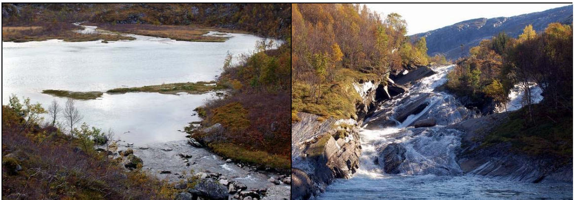
Figur 18 Tv: Utløpet av Vann kote 312 er trangt med bratt terreng på begge sider. Th: Storelvas elveleie har stor kapasitet ned mot utløpet i fjorden.
