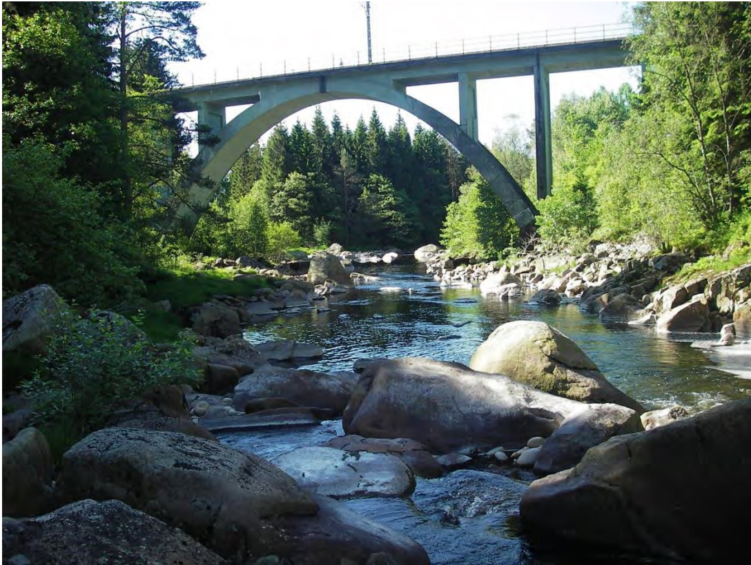
FIGUR 26: BILDET VISER JERNBANEBOEN OVER LITLEÅNA..
