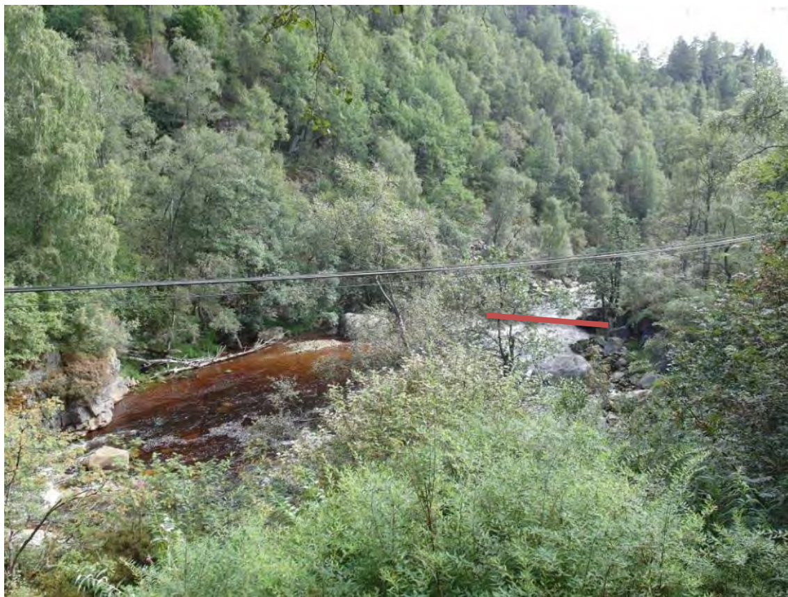
FIGUR 6: VISER MOT INNTAKSOMRÅDET FOR KRAFTVERKET. SELVE INNTAKSDAMMEN ER PLANLAGT NEDENFOR HØLEN I BILDET (RØD STREK).
