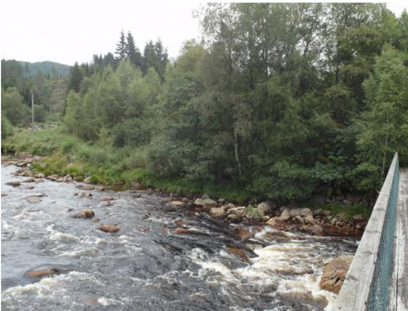
Bilde 2.2 Område for kraftstasjon på østre bredd ovenfor den gamle broa.
