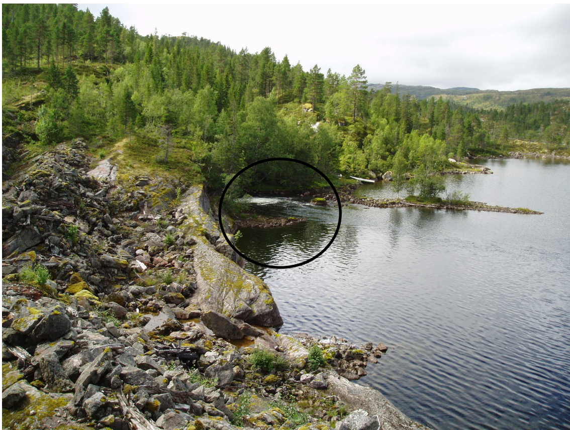
Bildet viser området for planlagt rør i grøft og permanent vei fra dammen i Storvatnet til planlagte Storvatnet kraftstasjon. Til høyre på bildet er Damtjørna. Sort sirkel viser utløp tappetunnel.
