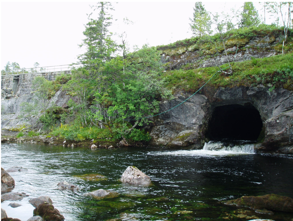
Bildet viser utløpet av tappetunnelen fra Storvatnet til Damtjørna.
