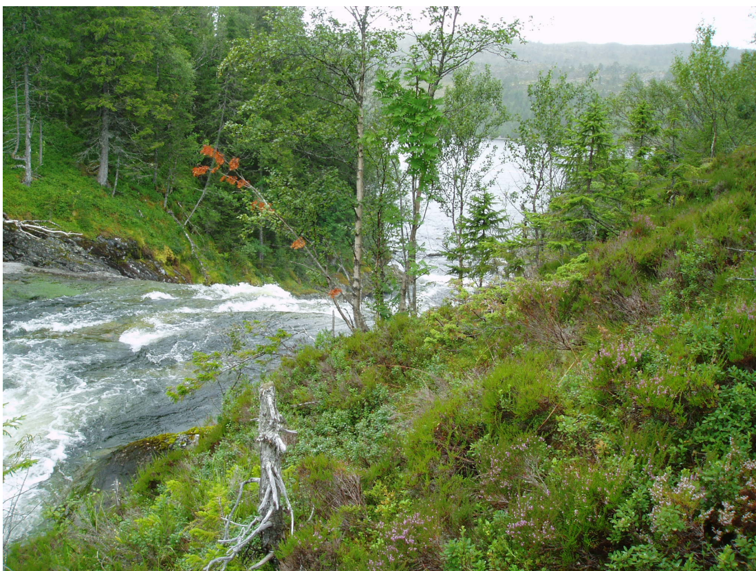
Bildet viser terrenget hvor det er planlagt rør i dagen ned til kraftstasjonen. På bildet er planlagt vannvei på venstre side av fossen. Dette er et vanskelig parti for rørtraseen og det må utføres en del sprengingsarbeider her.
