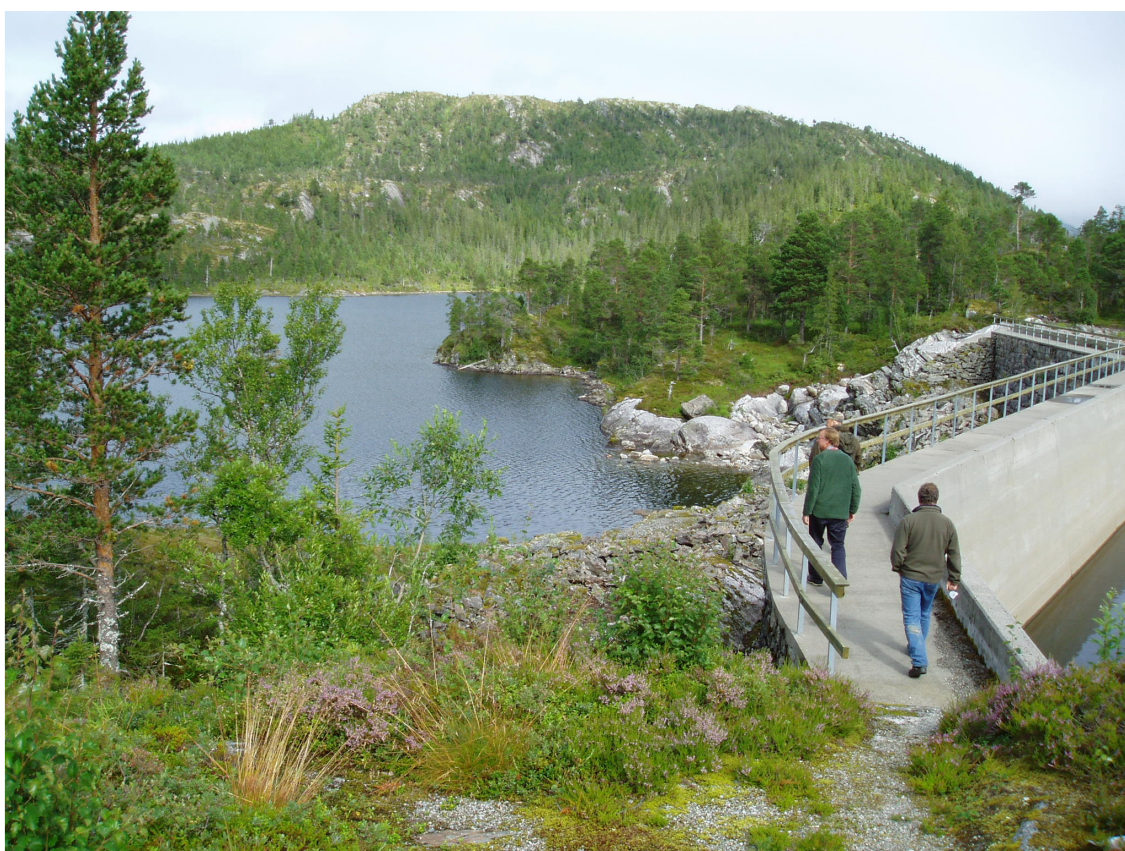
Bildet viser dammen i Storvatnet. Storvatnet er på høyre side av dammen og Damtjørna er på venstre side. Tappetunnelen går under der det passerer personer over dammen.
