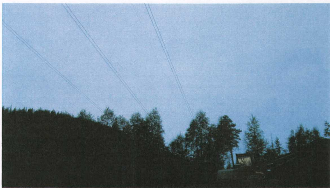
Langtjønnebrua 420 kV ledning 12.08.2007 (rel 950)
