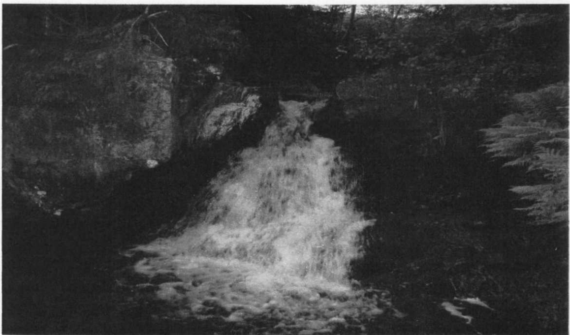
Sagvollfossen 22.06.2007 (Vatnet fra vassledningen er kommet til v/ kloringsanlegget) (p. 2000)
