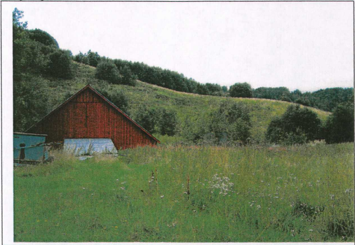
Kraftverket blir til høyre i bildet
