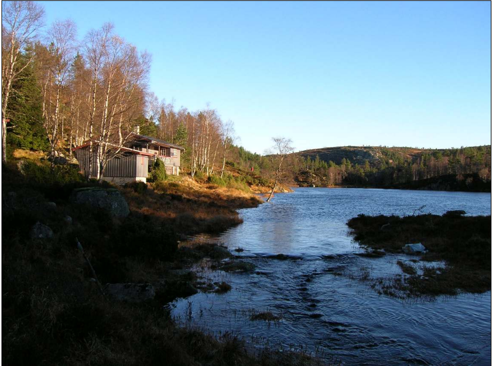
Figur 25: Utløpet til Vatjødne. Dempingsterskelen vil komme ca midt i bildet. Topp på terskel vil bli omtrent som vannspeilet er på bildet. Bildet er tatt en dag med stor vannføring, 1 november 2006.
