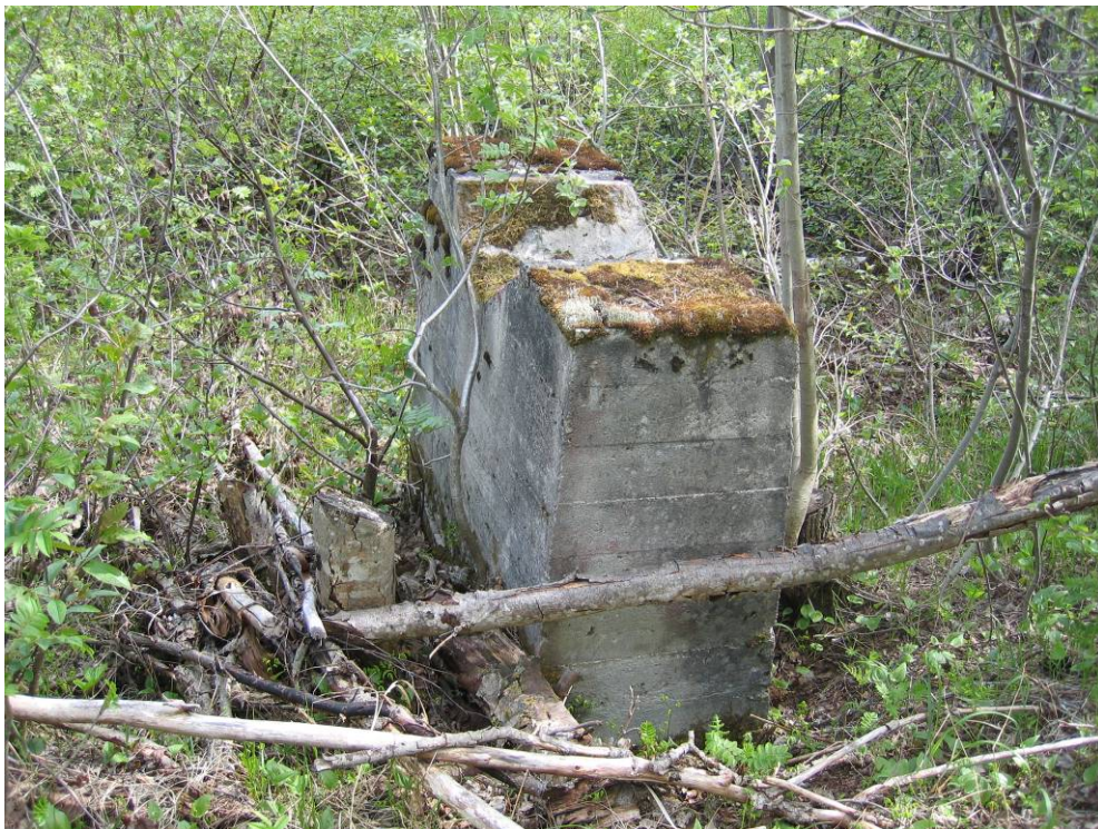
Fundamenter for gammel rørgate
