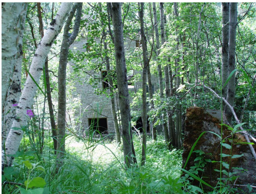
Gammel kraftstasjonsbygning. Den nye er foreslått til 40 meter til høyre for denne.
