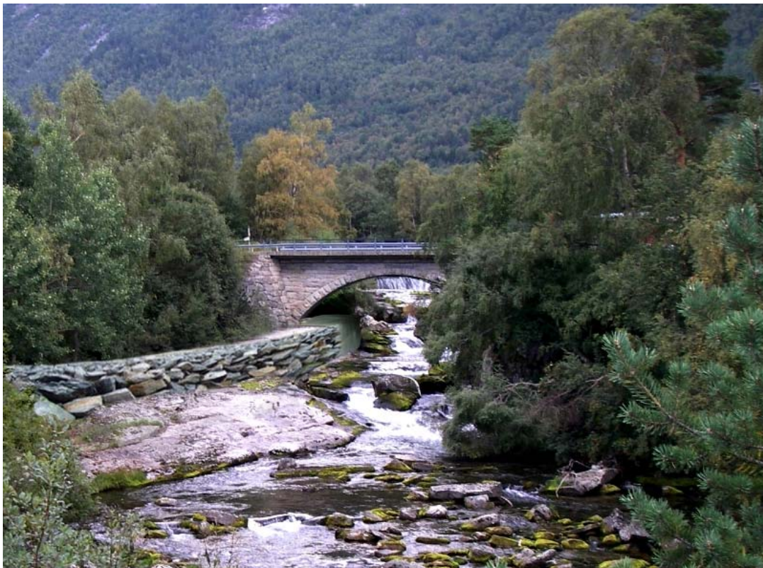
(Sett fra den gamle brua)
