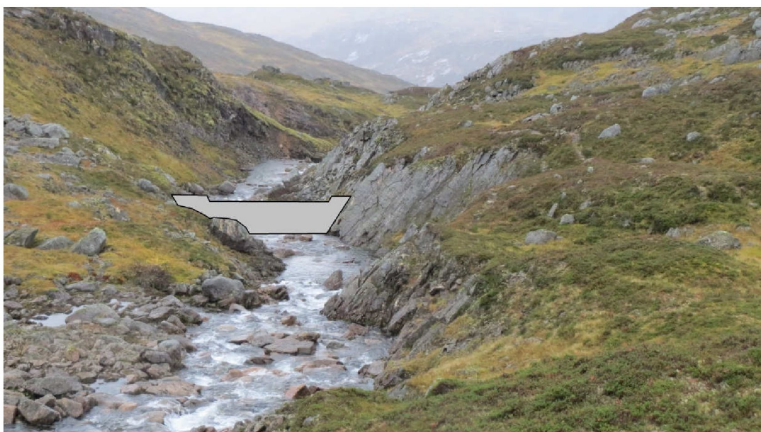
Figur 5: Inntaksted kote +426 – sett ovenfra
