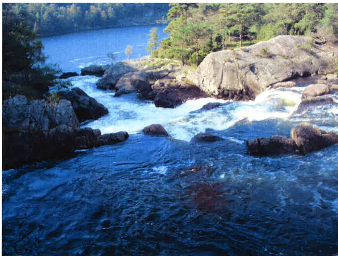
Bilde 10: Frøytlandsfoss sett nedstrøms inntaksterskel.
