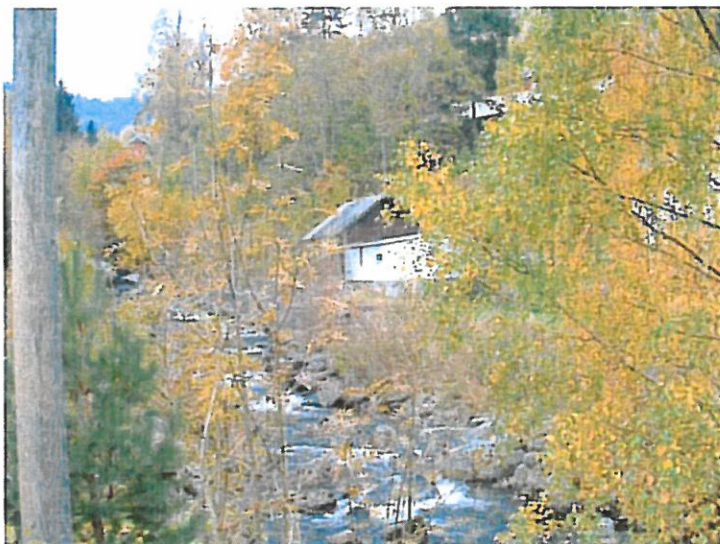
Figur 7. Kraftstasjon ved Trisæ (2/3)
