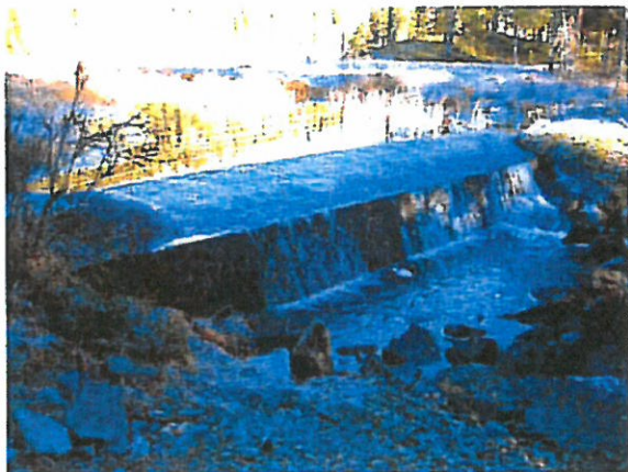
Bilde 2. Overløpsdam i betong nordvest for hoveddammen
