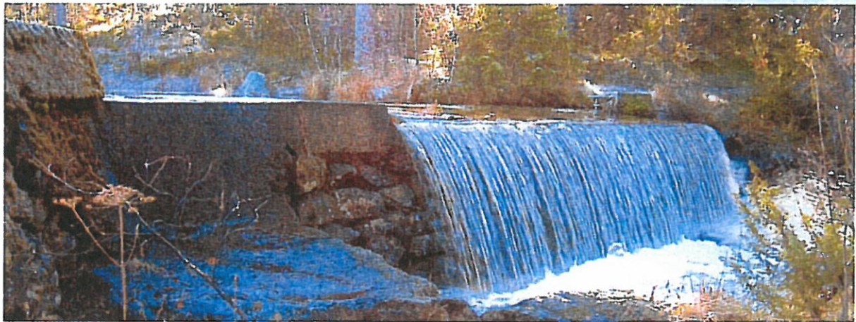
Bilde 1. Bildet viser deler av Dam Nossevatn , bl.a overløpet. Lengst borte kan skimtes rattet for opptrekk av luke med skruespill.
