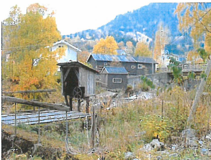
Figur 8. Inntak kraftstasjon Trisæ (2/3)
