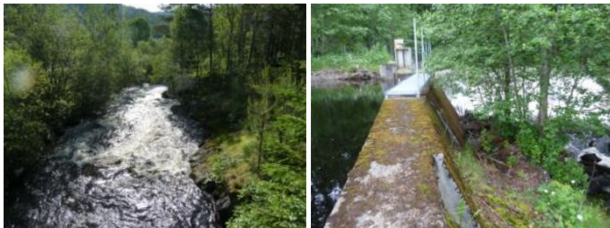
Figur 3. Til venstre frå inntaket på Kleivi på toppen av Kvålofossen, sett frå Straume bru. Til høgre frå inntaksdammen (Nydam) til Bandaksmolt.
