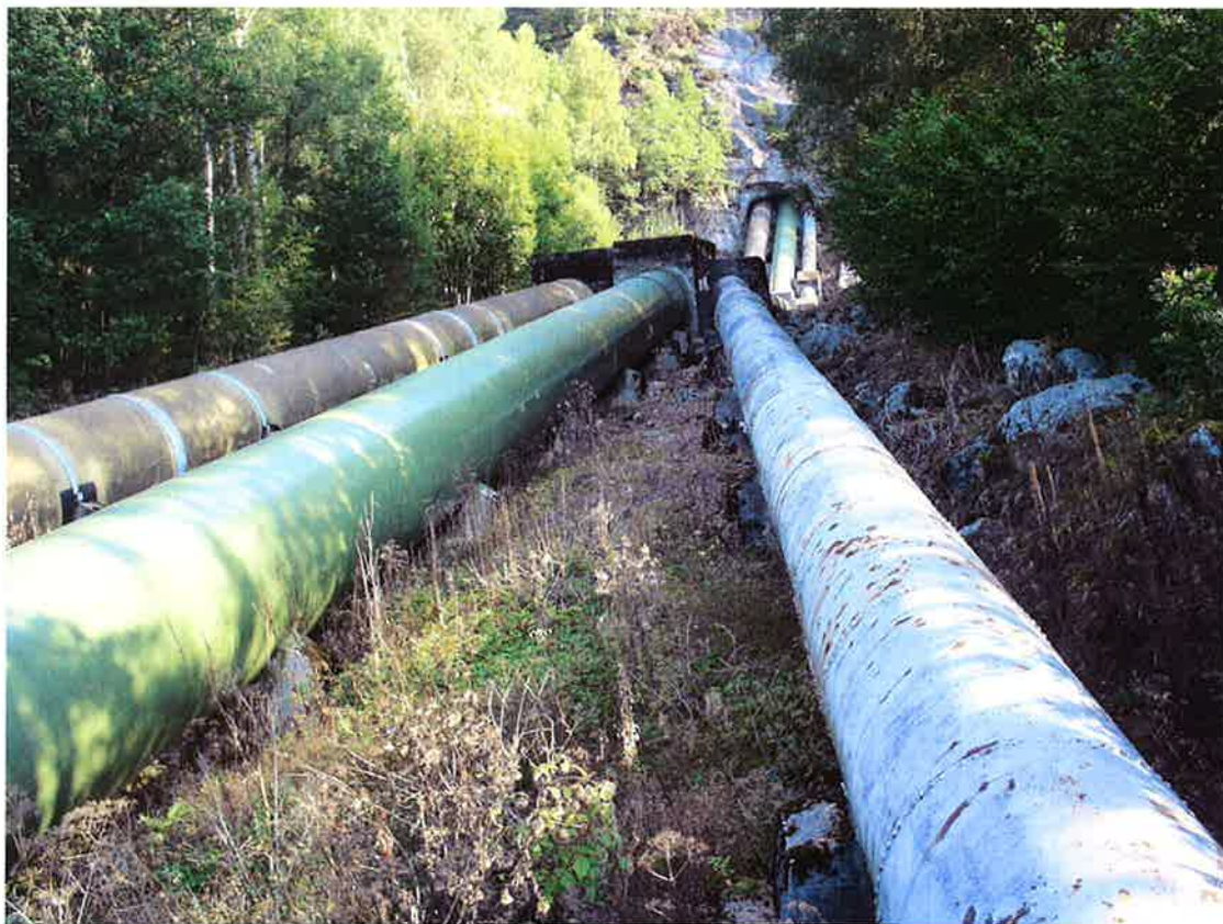
Bilde 9: Rørgaten inn mot kraftstasjonen, sett oppstrøms
