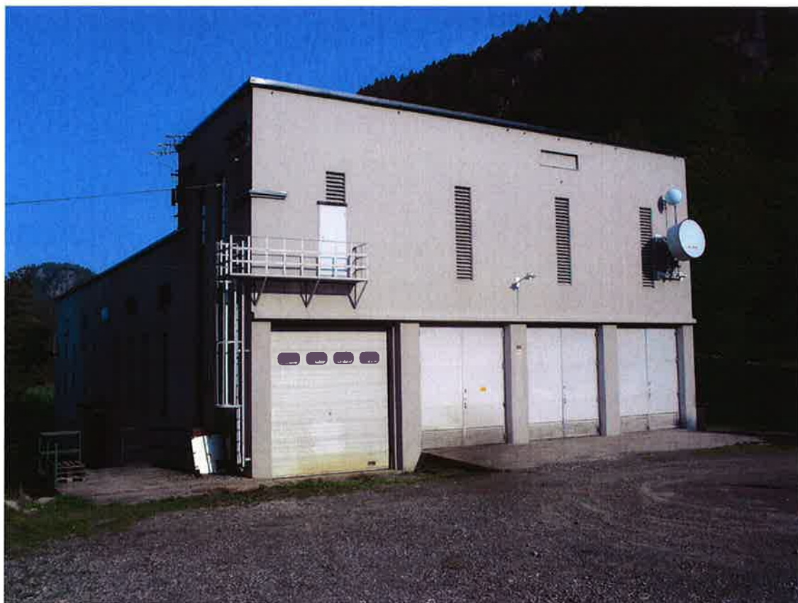
Bilde 10: Høylandsfoss kraftverk
