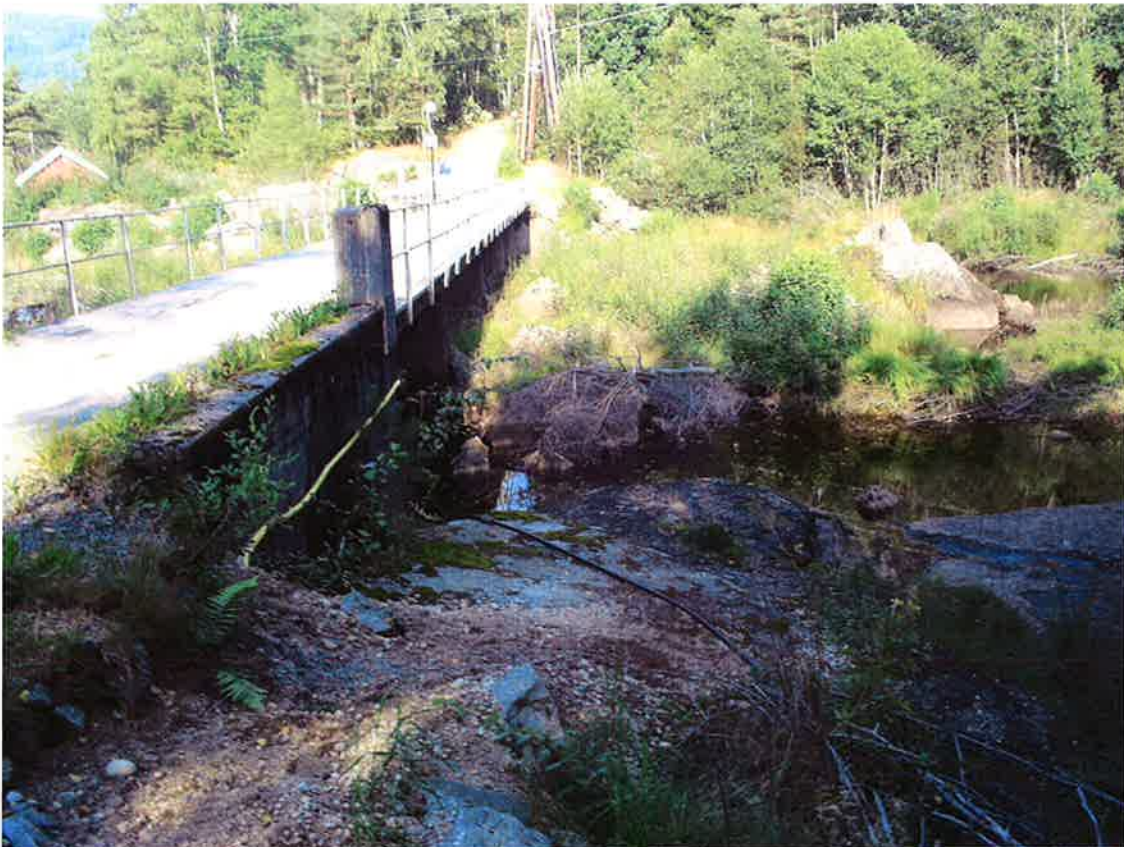
Bilde 6: Atkomstbrua til kraftstasjonen
