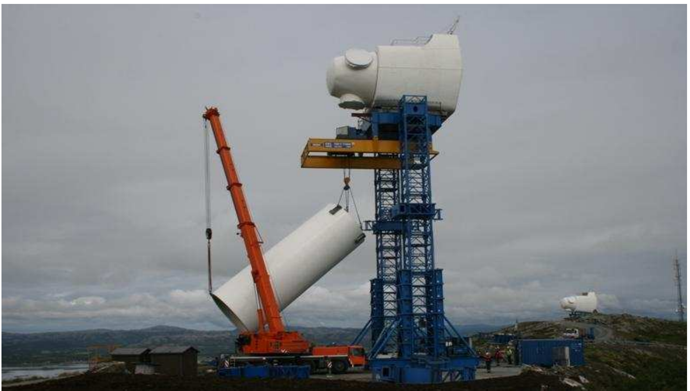
Bilde 9-15 Montasje av Scanwinds SW 3500DL på Hundhammerfjellet. Foto: Scanwind
