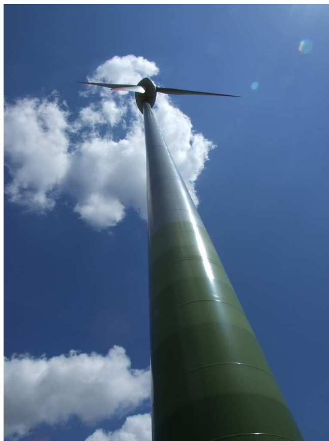
Bilde 6-7 Kombineres vindenergi og jordbruk er arealeffektiviteten svært høy.
