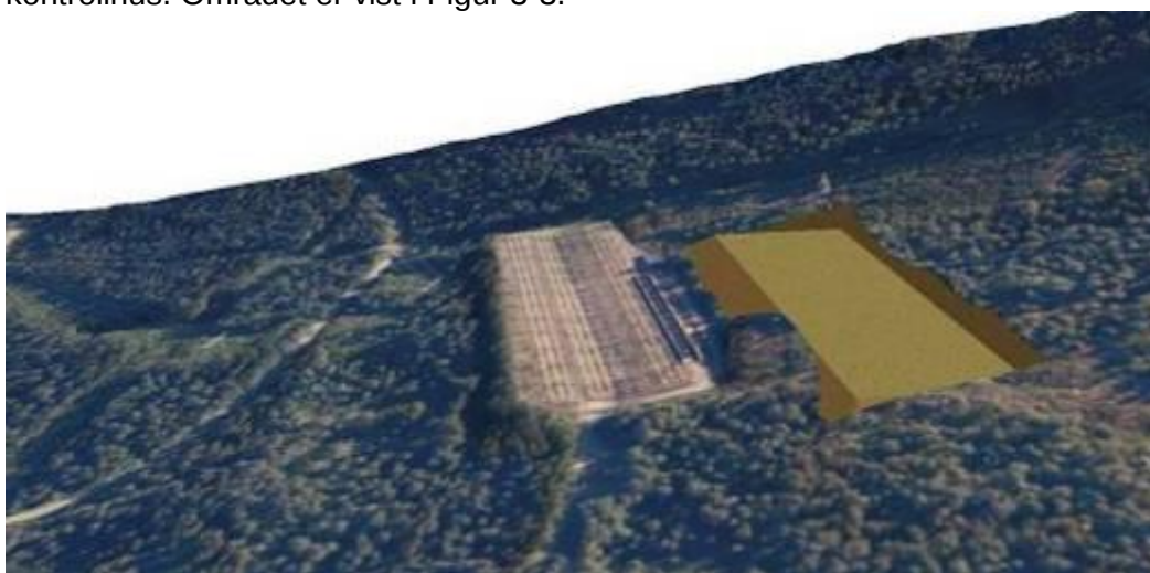
Figur 3-3. Flyfoto som viser utvidelse av eksisterende 300 kV koplingsanlegg til 420 kV anlegg.
