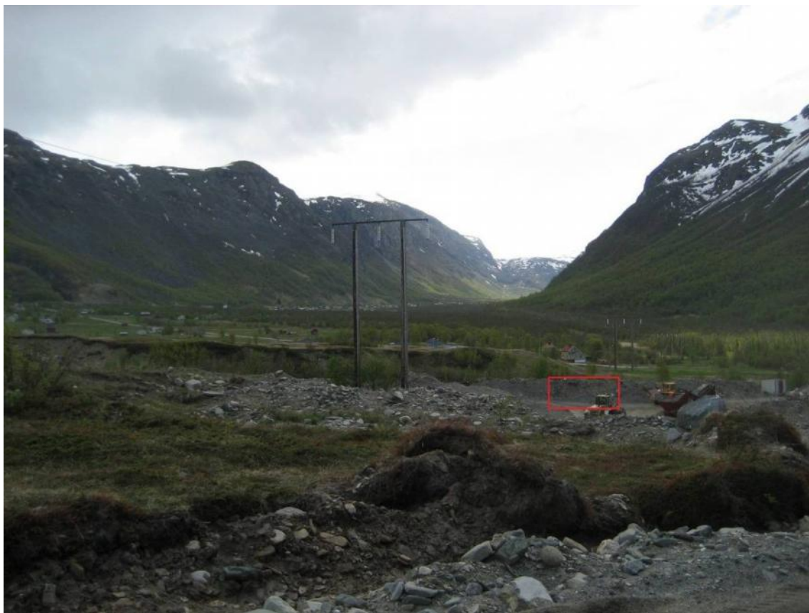
Bilde 5: Kraftstasjonsområde i grustaket, kraftstasjonsbygg i rød firkant. Foto: Elvekraft
