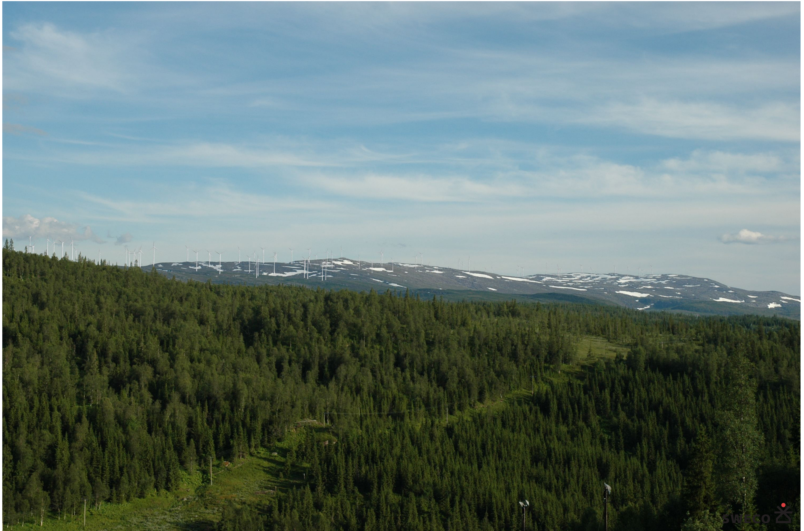
A) Mosjøen vindkraftverk sett fra Kjemsås alpinanlegg mot sørøst. Fotografi tatt: 03.07.2007 kl. 19.22.
