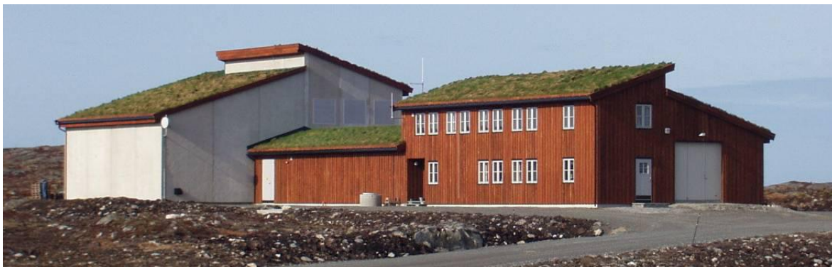
Figur 4.17. Eksempel på 132/33 kV trafotrafostasjon i parken (bildet viser Smøla trafostasjon og er kun ment som illustrasjon)
