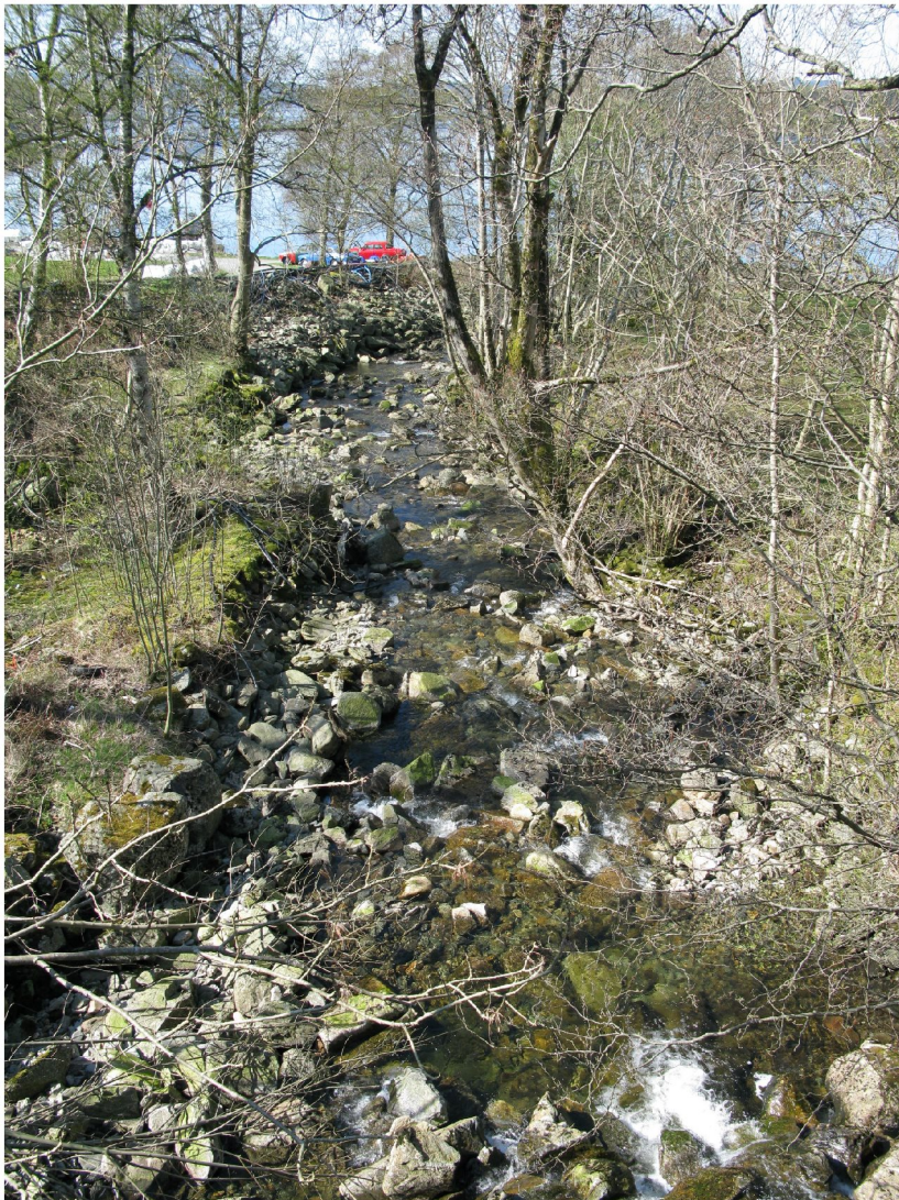
Figur 2. Nedre del av Aksdalselva sett fra vegbroa.
