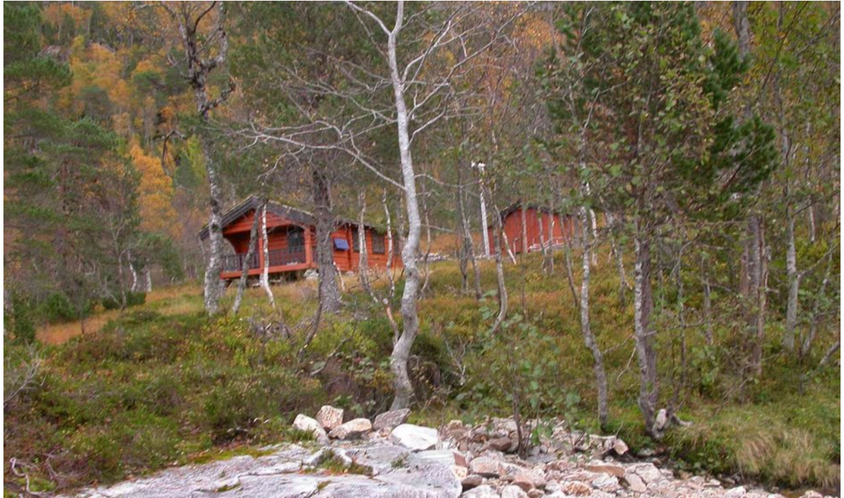
Figur 2. Litt nedom det planlagde inntaket ligg det ei ganske ny hytte. Her er det montert både ei lita vindmølle og eit lite 12-volts vassdrive straumaggregat. (Foto FGO ©)
