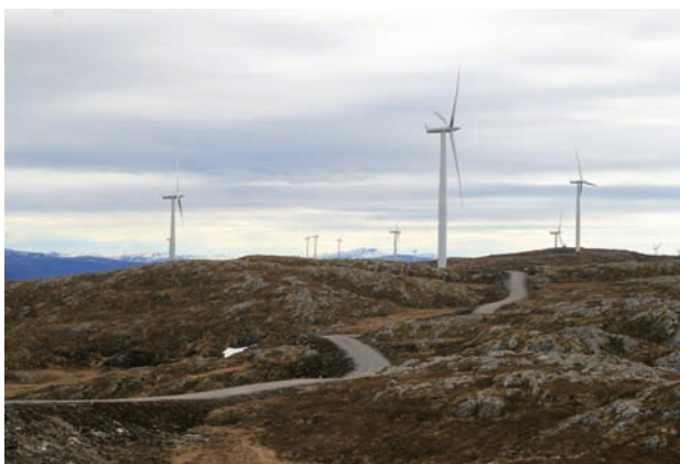
Figur 6-2 Interne veier. Eksempel fra Hitra vindpark (Foto: Trond Simensen, Sweco)
