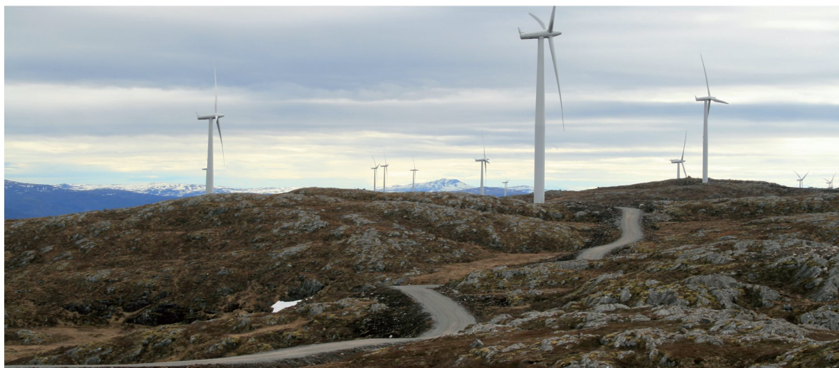
Slik kan vindparken med internveier se ut. Eksempel fra Hitra vindpark. Foto: Trond Simensen, Sweco
