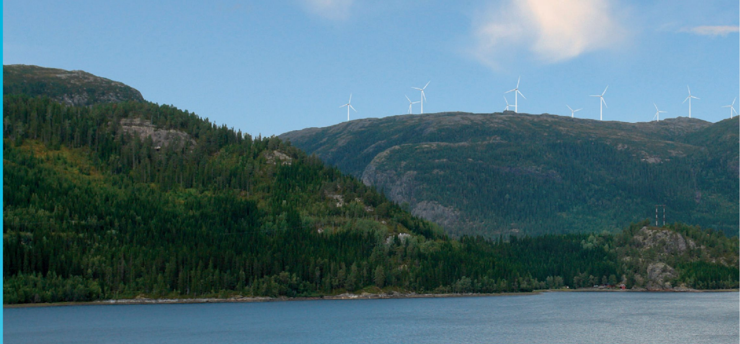
Breivikfjellet vindpark sett fra småbåthavn vest for Bangsund. Foto og visualisering: Sweco
