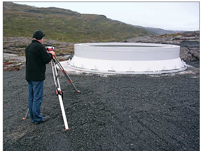
Montasje og oppmåling av fundament for 2,3 MV turbin på Nygårdsfjellet vindpark.
