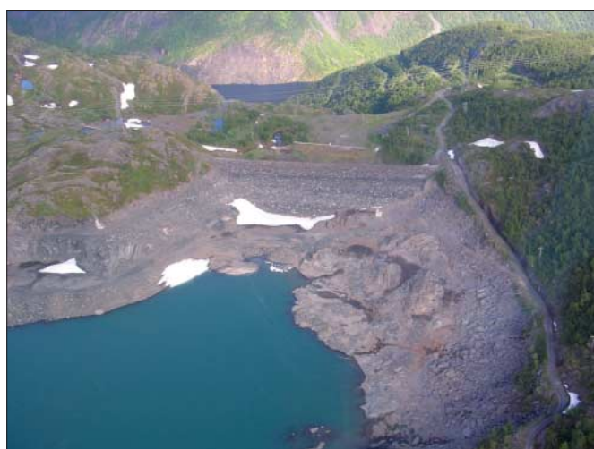
Brynassdammen og deler av anleggsveien som kommer opp fra Sørfjorden
