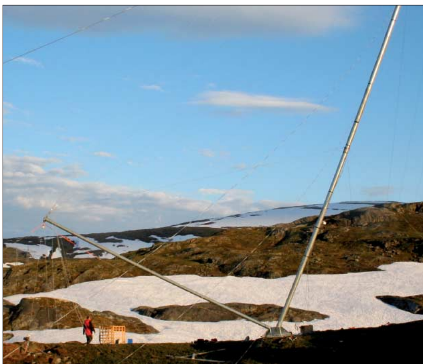
Arbeider med montasje av vindmålemast.
