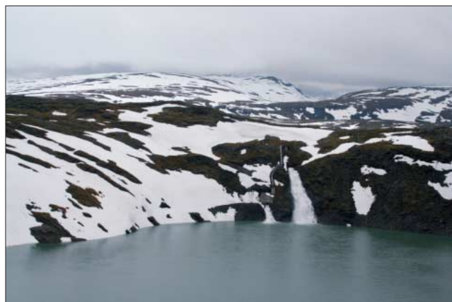
Innerenden av Brynvassdammen. I bakgrunn vises Sørfjord II kraftstasjon.
