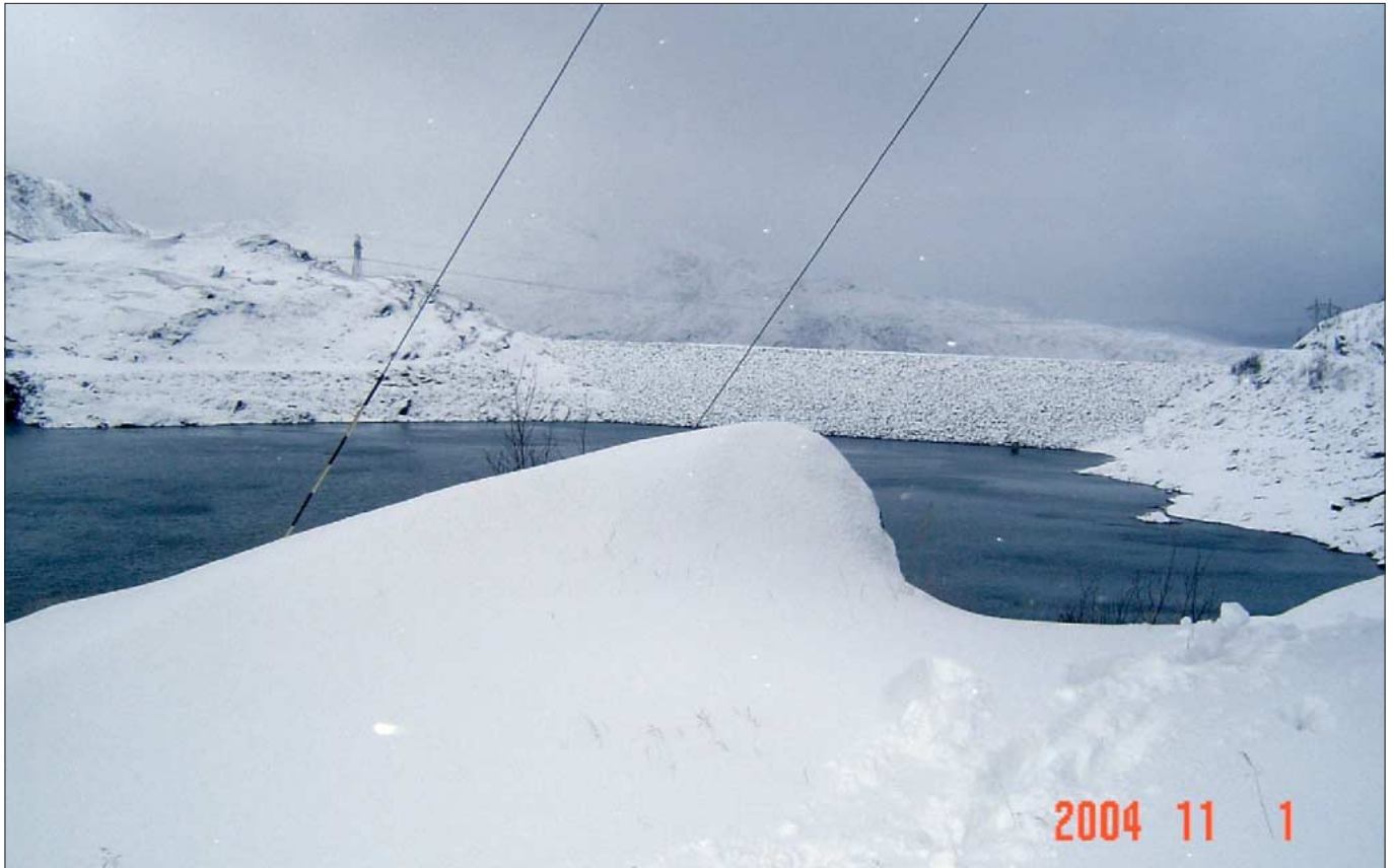
Brynvassdammen på forvinteren sett fra anleggsveien.
