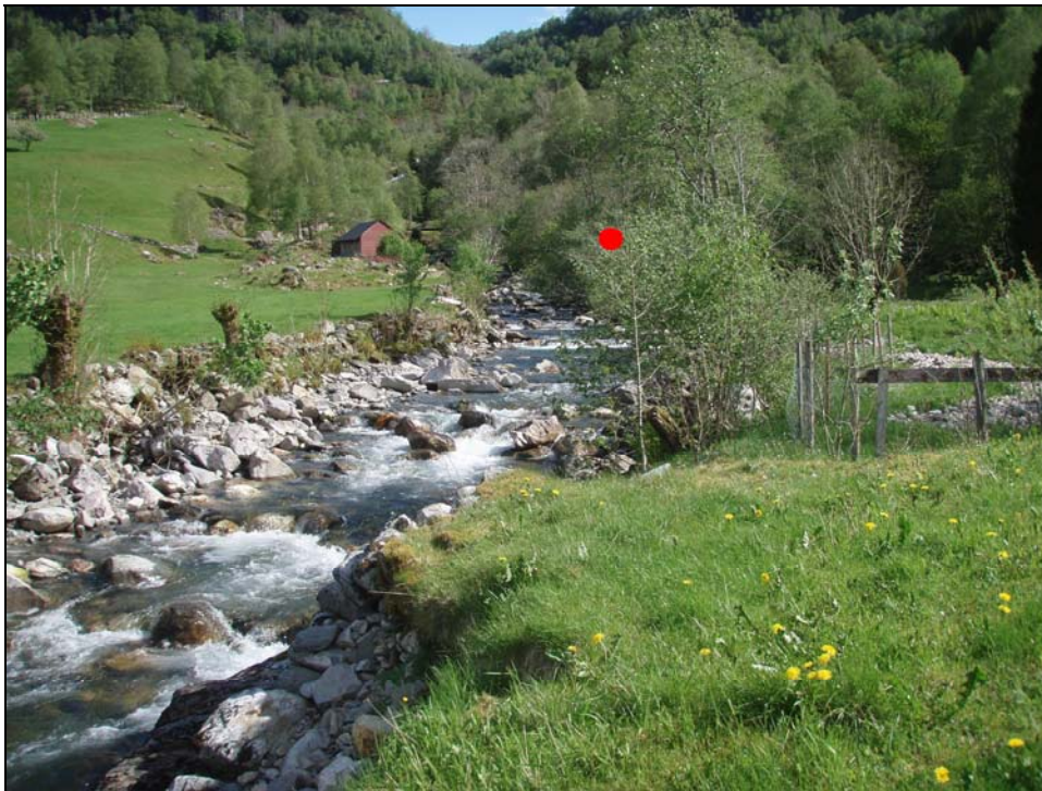
Figur 3.1.2.c Kraftstasjonen skal plasserast på austsida av elva ved kote 56 (jf. raud markering). Område ved stasjonen er kledd med eit tett lauvskogsholt, og gjer til at det vert sterkt avgrensa innsyn i sommarhalvåret. På vestsida av elva står ein bygning som vart nytta som kraftstasjon fram til 1950-åra. Vatn frå Gjønaelva vart også då nytta til produksjon av elektrisk kraft.
