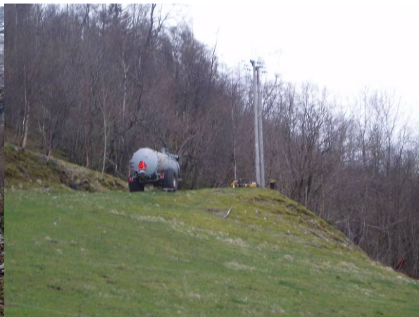
Bilete nr. 8 22 kV høgspenline 200 m frå planlagt stasjon.
