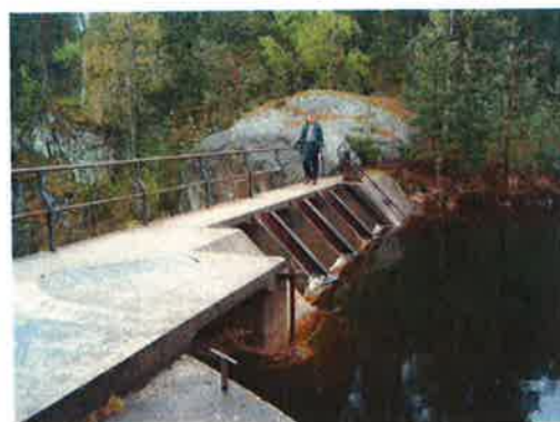
Eksisterende dam Savann, oppstrømside
