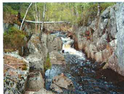
Sprengt kanal fra Ljøsvannet
