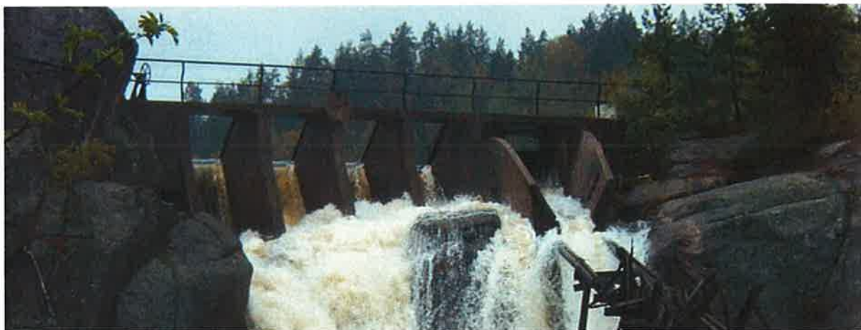
Eksisterende dam Savann, nedstrømsside
