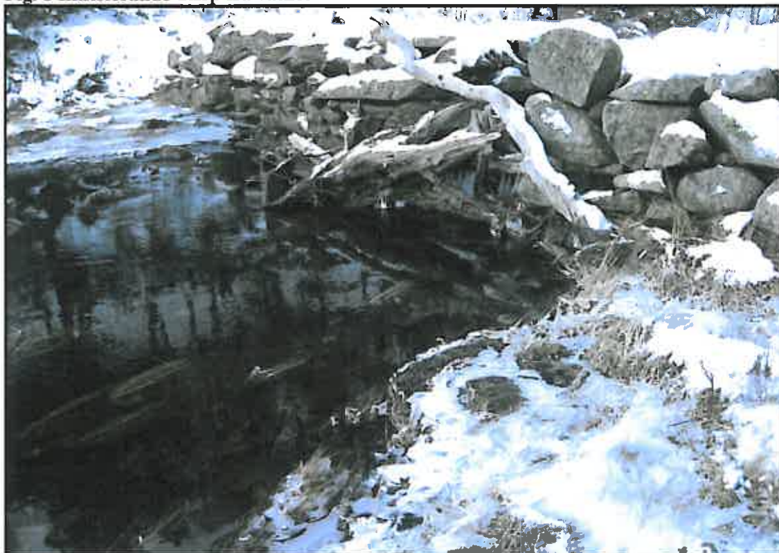
Fig. 8 Eksisterande utløp frå vatnet
