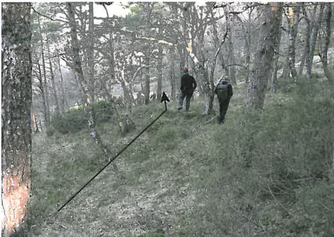
Bilete 10 Rørgata svingar fortsatt mot nord og frå kote 400 som bilete viser, blir det lagt duktile stålrør
