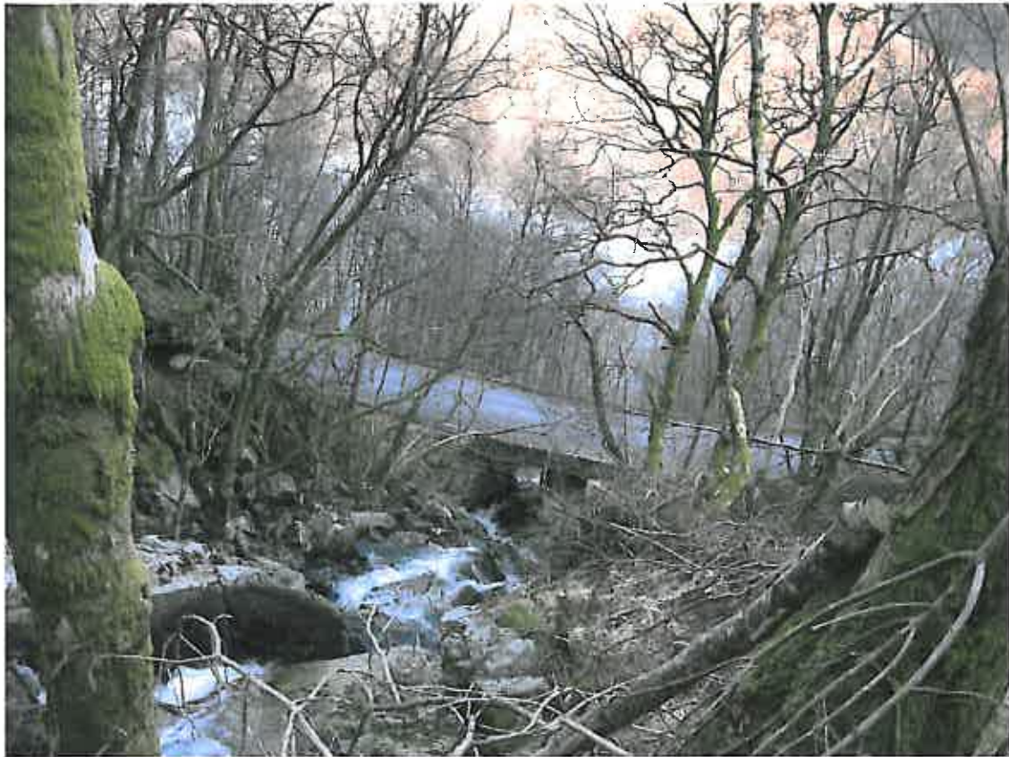
Bilete 20 Liarelva kryssar fylkesvegen under brua på kote 65
