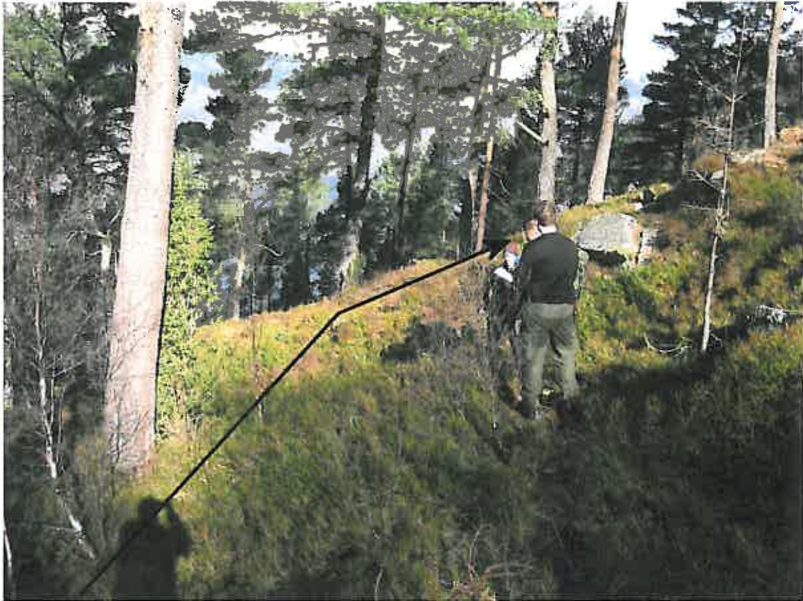
Bilete 9 Rørgatetraseen (fortsatt PE) tek av frå eksisterande elvelaup og svingar mot nord
