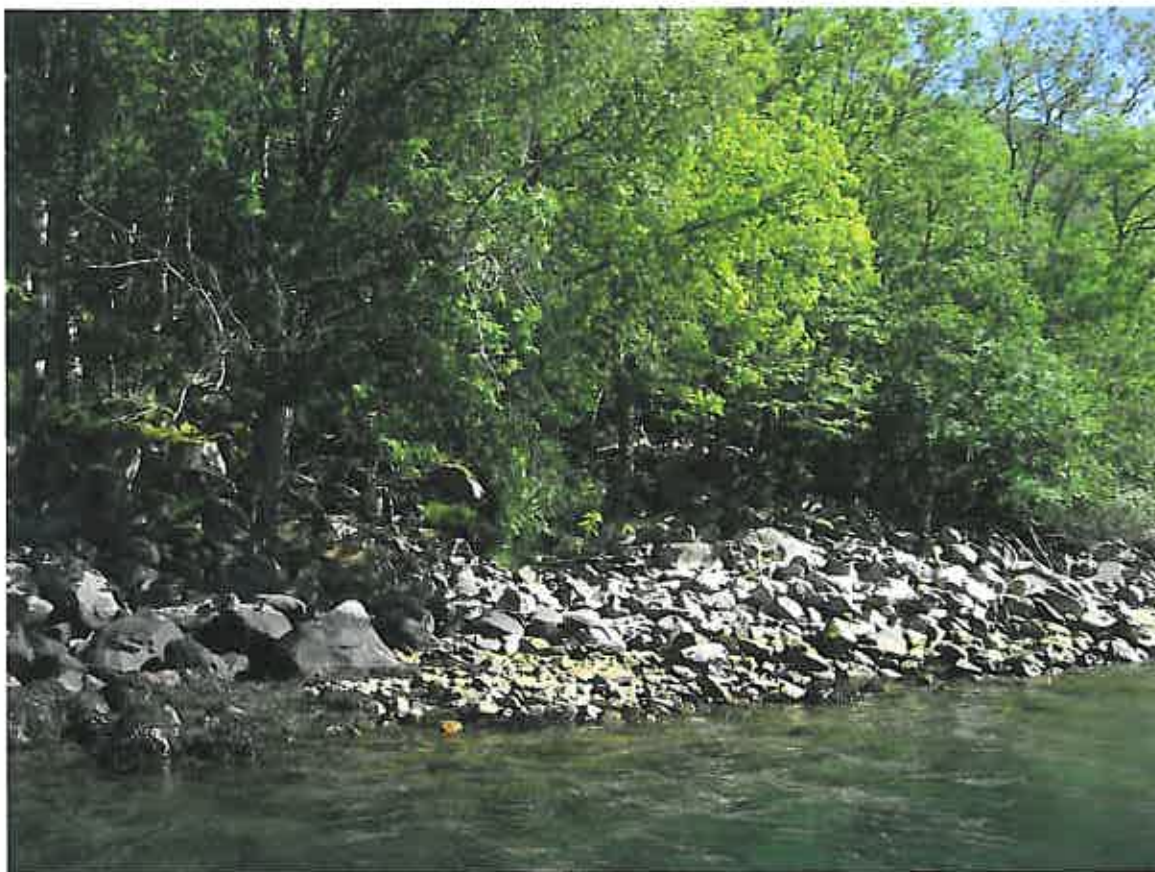
Bilete 24 Vatnet fordeler seg i utløpet slik at det er lite synleg frå sjøen
