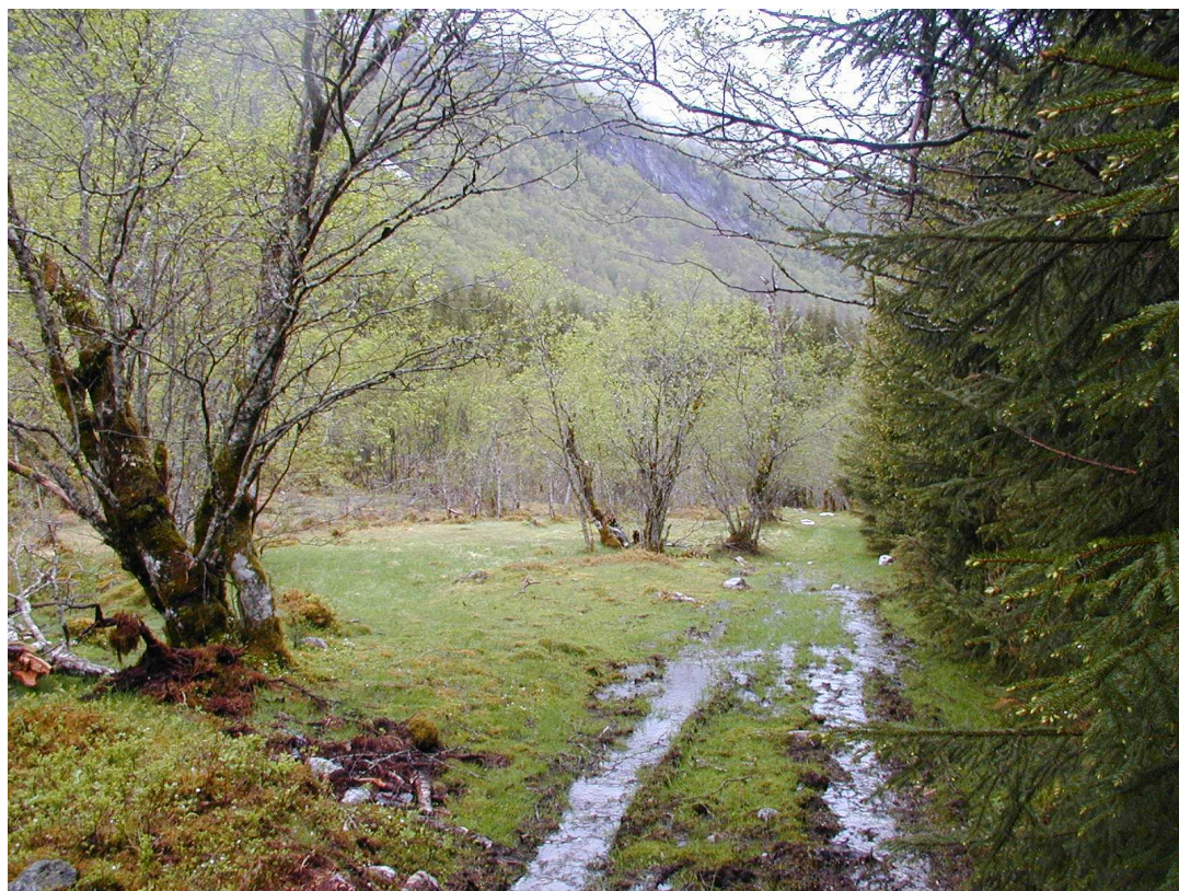
Foto 4 Nedre del av rørtase, sett nedover. På dette partiet er begge rørene gått sammen til et rør ned mot kraftstasjonen.
