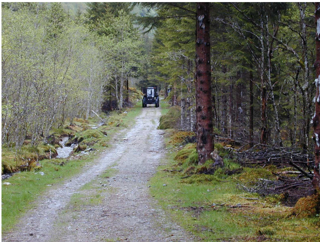
Foto 1 Eksisterende vei like nedenfor kraftstasjon. Bilde er representativt for dagens vegstandard i dalføret.
