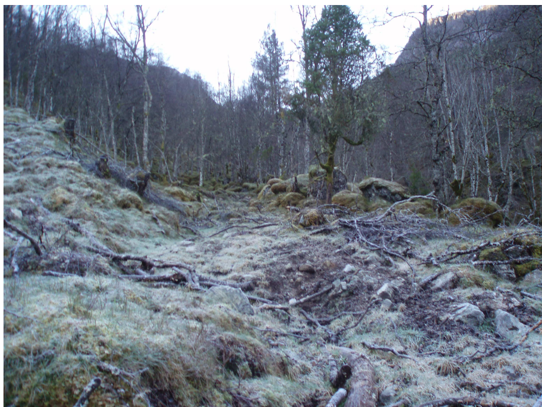
Foto 11 Rørtrase mot inntak i Breidalselva.
