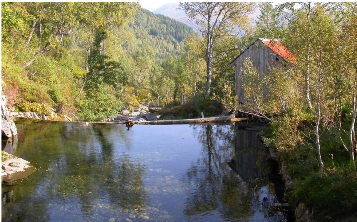
Figur 8. Her ser ein den gamle inntaksdammen til vassverket Den tener no som reserveinntak, og det er her tiltakshavarane har tenkt at den nye inntaksdammen til kraftverket skal liggja.
