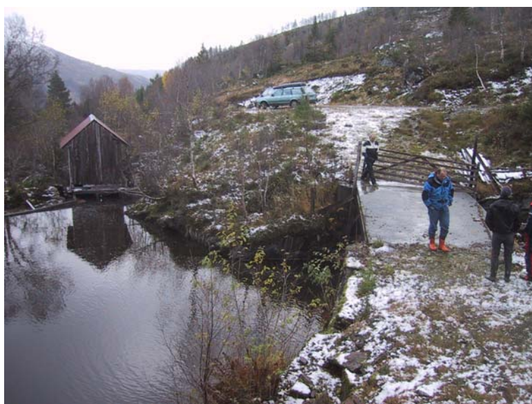
Stad for inntak.
