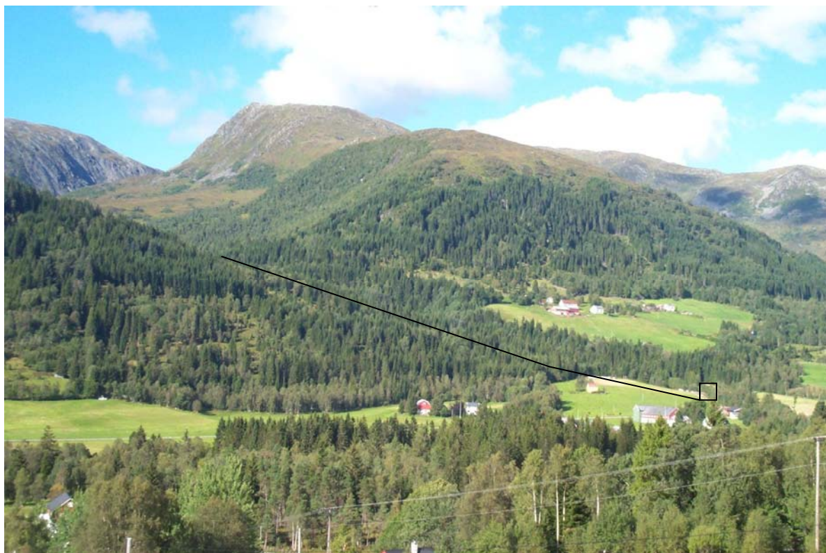
Utbyggingsområdet med Kjørstadelva skjult av skogen. Streken angir tilløpsrøret og firkanten angir kraftstasjonen. I framgrunnen passerer 23 kV linja som kraftverket skal knytast til.
