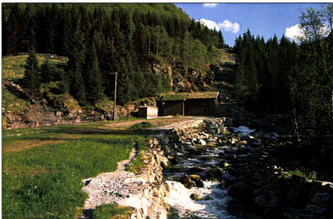
Figur 4. Kjetland kraftverk utnytter fallet i nedre del av Dalelva. Inntaket til denne kraftstasjonen ligger like nedenfor foreslått kraftstasjonsområde for Dalelva kraftverk.
