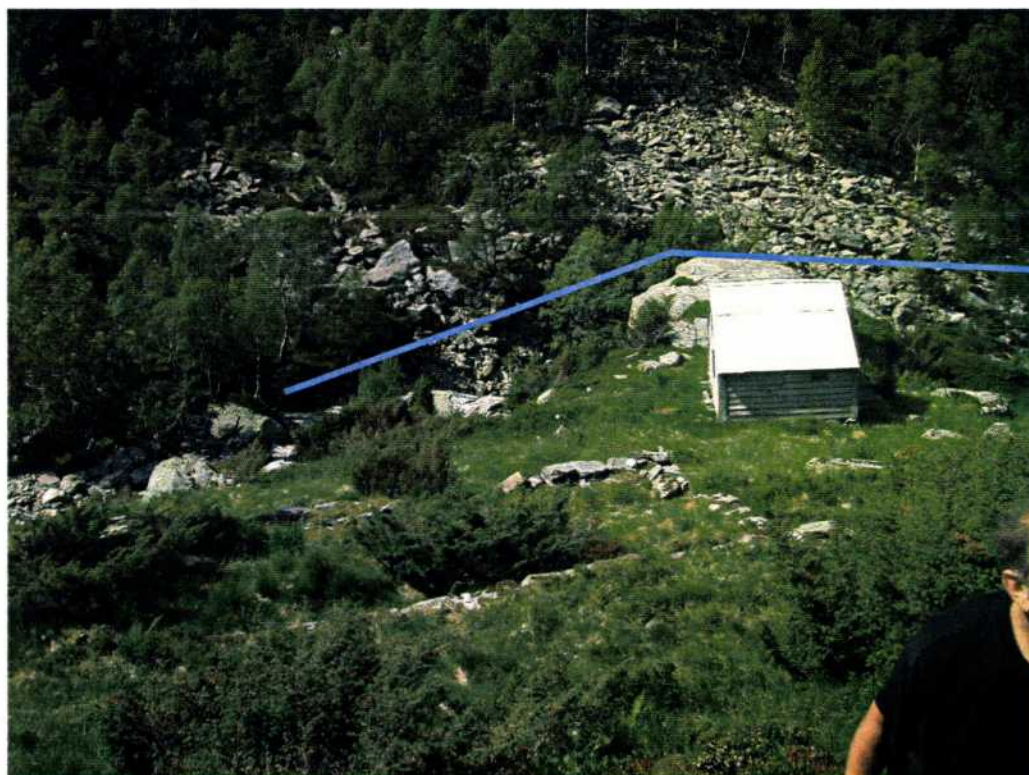
Bilde 6: Oversikt rørgate, damområdet.
