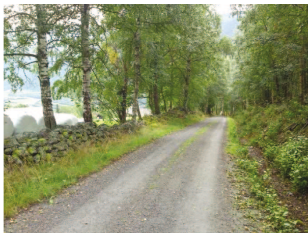
#08 - Området hvor rørtraseen vil krysse vegen
