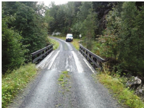
#02 - Bru på nedsiden av inntaksområdet
