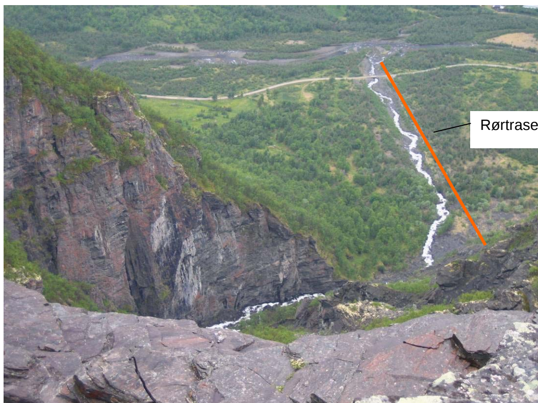
Bilde 6: Oversikt rørgate og kraftstasjonsområdet
