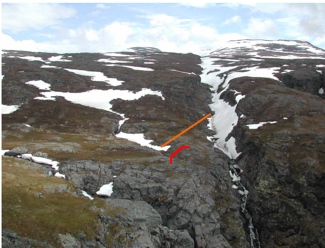
Bilde 2: Overføring, dam og inntaksområdet
