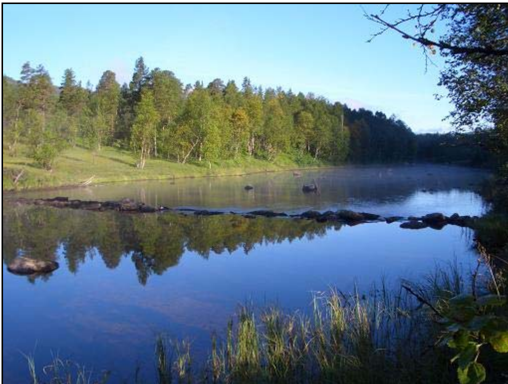
Foto 6: I elva er det etablert flere terskler som hever og danner et stilleflytende vannspeil. Dette er et naturforbedrende tiltak etter en tidligere kraftutbygging.
