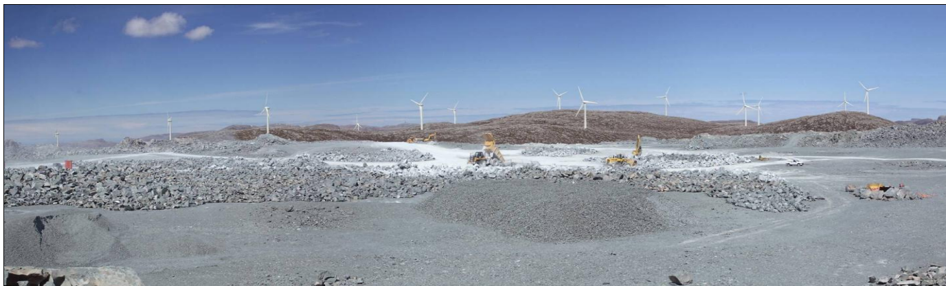
Figur 18. Marafjellet vindkraftverk sett fra Sætrfjellet (fotostandpunkt 1).
