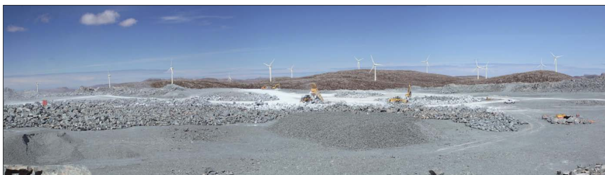
Figur 37. Vindkraftverket sett fra steinbruddet på Sætrefjellet viser nærvirkningene av vindturbinene. (Fotostandpunkt nr. 1).
