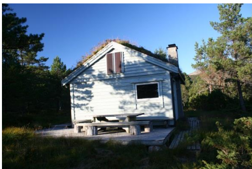
29. Hytte på stølstuft Sted: Dyrstadstøylen SEFRAK-ID-nr.: Nyregistrert Registrert av: Torbjørn Røberg, Odel Dato: 7.9.2010
