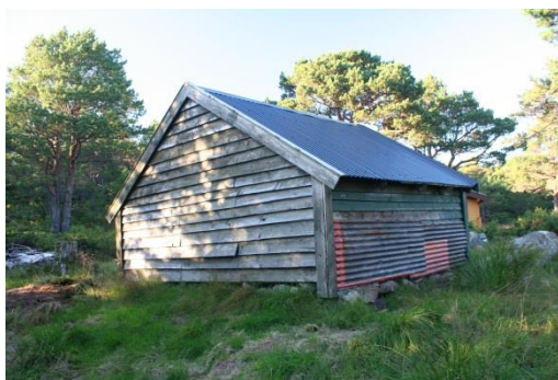
30. Hytte på stølstuft Sted: Dyrstadstøylen SEFRAK-ID-nr.: Nyregistrert Registrert av: Torbjørn Røberg, Odel Dato: 7.9.2010
