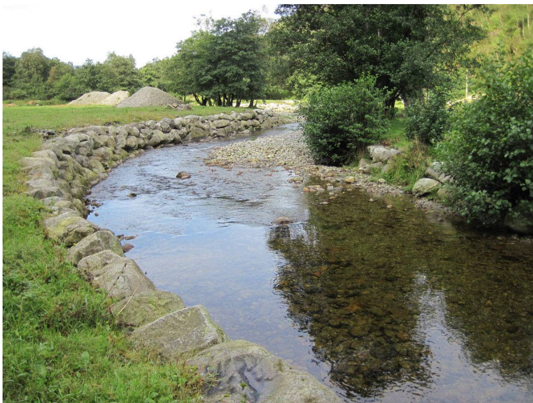
Bilde 3 Forsandåna nedenfor planområdet: Også her er deler av strekningen steinsatt og kantvegetasjon er delvis fjernet.
