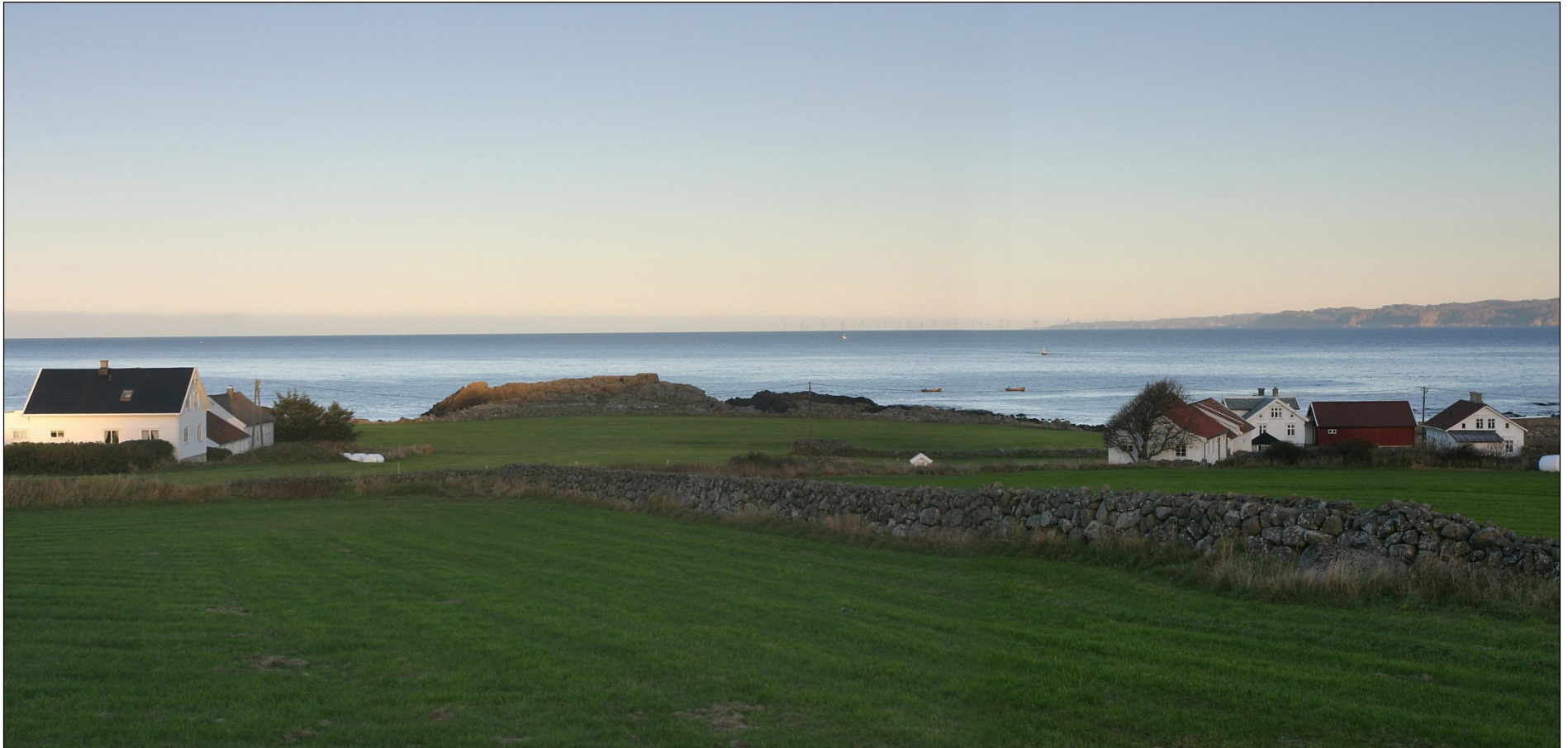
Figur 38. Siragrunnen Vindpark (alt. V1) sett fra Jølle på Lista (Farsund). Vindparken kan så vidt skimtes i det fjerne. Bilde­standpunkt 1.
