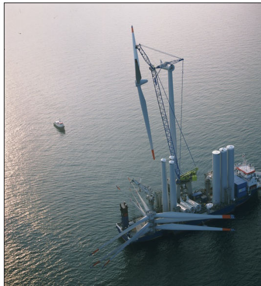
Figur 20. Fra monteringen av vindturbiner ved Nysted Havmøllepark, Danmark. Foto: Jan K. Winther. Kilde: www.nystedhavmoellepark.dk
