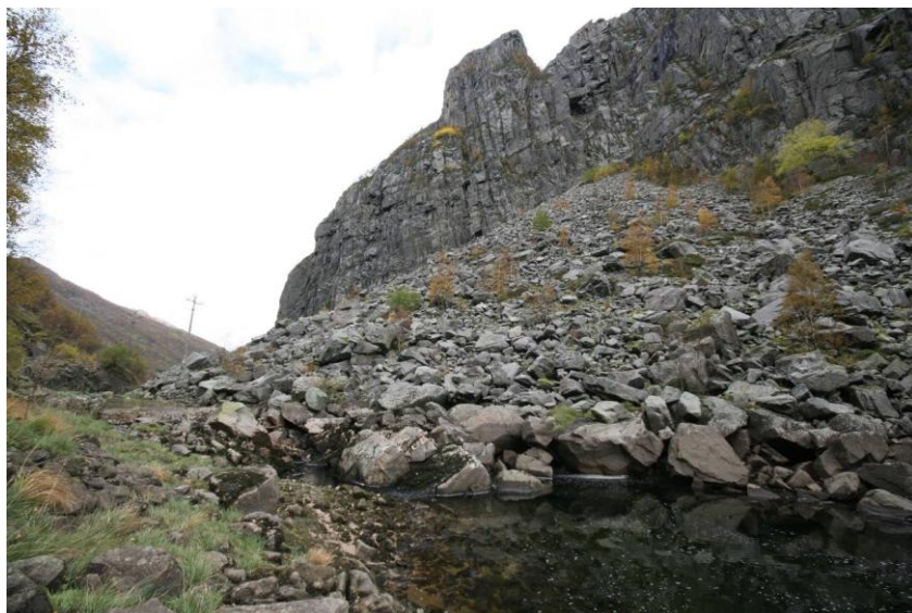
Figur 5-5. Bildet er tatt fra damområdet mot den planlagte terskelen i Byrkjedalsvatnet og viser den nederste delen av rasmarka som fortsetter oppover til høyre i bildet. Foto: H. Gregersen.
