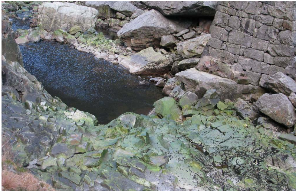
Figur 10. Punkt 7. Vandringshinder ved Utløpet av Lona. Ved lave vannføringer forsvinner elva i ura ved utløpet av Lona. Ca. 100 m nedenfor ved gammelt brukar kommer vannet frem i dagen.
