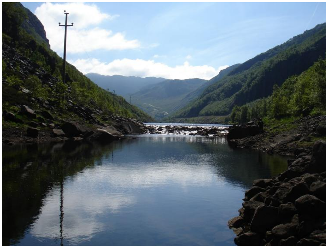
Figur 5-2 Øvre landskapsrom. Eksisterende terskel i Byrkjedalsvatnet.
