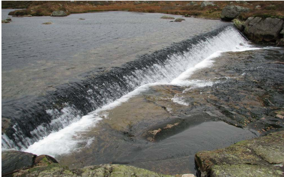
Figur 12. Punkt 10. Vandringshinder eller vandringsstengsel. Sett nedenfra. Laksefisk vil trolig kunne gå opp til terskelen men ha problemer med å passere denne.
