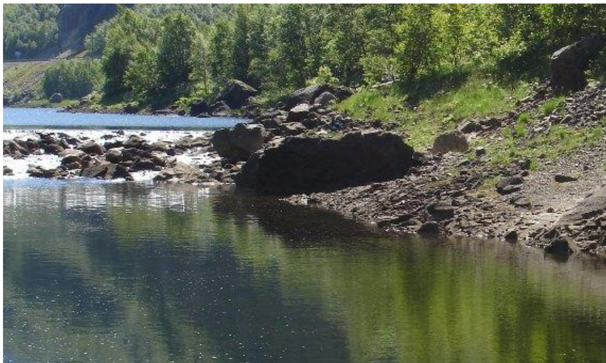
01 Dykket inntak i alternativ A i Byrkjedalsvatnet rett oppstrøms eksisterende terskel. Lukehus i vegetasjonen til høyre på bildet (19. juni 2007).
