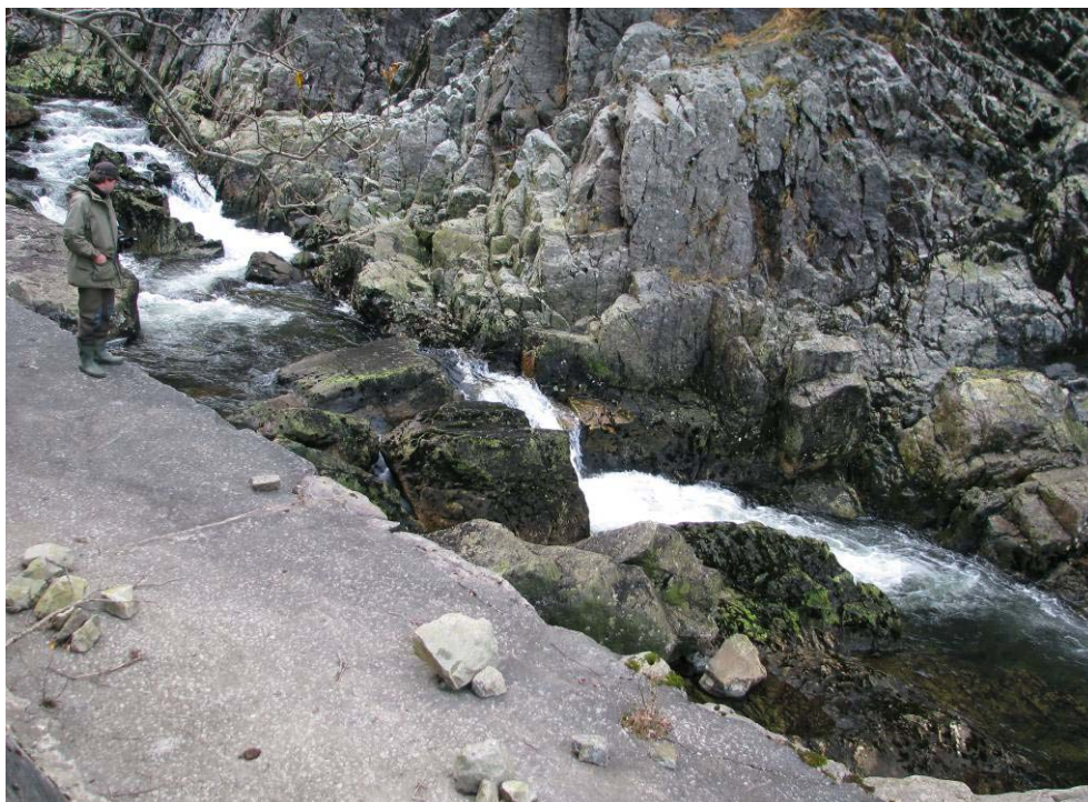
Figur 7. Punkt 4. Vandringshinder. Sett nedenfra..
