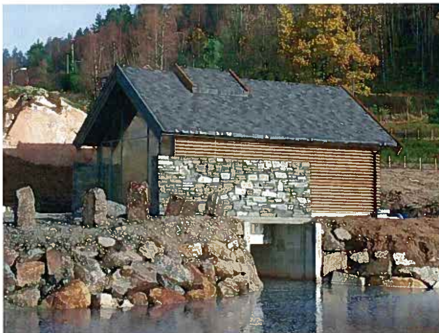
Bilde: Nybygd anlegg tilsvarende planlagt stasjon i Ljøelva.
