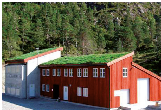
Figur 6-5 Transformatorstasjon og servicebygg (eksempel fra Hitra vindpark)
