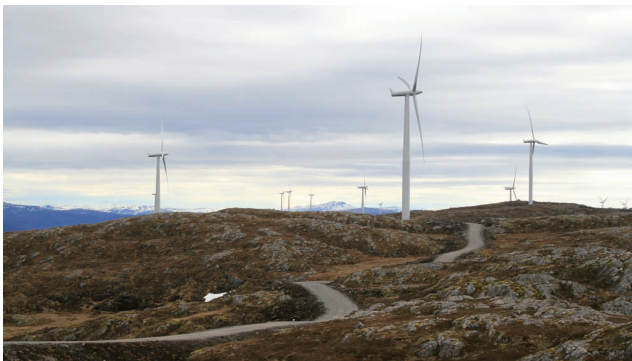
Figur 6-4 Internveier i vindparken på Hitra
