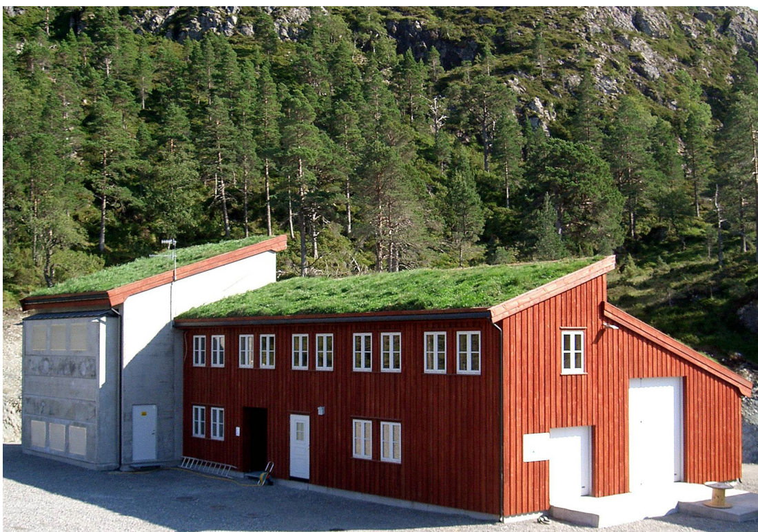
Figur 7: Transformatorbygget i vindparken på Hitra er et eksempel på hvordan transformatorstasjonen på Heimsfjellet kan bli. Foto: SAE Vind.
