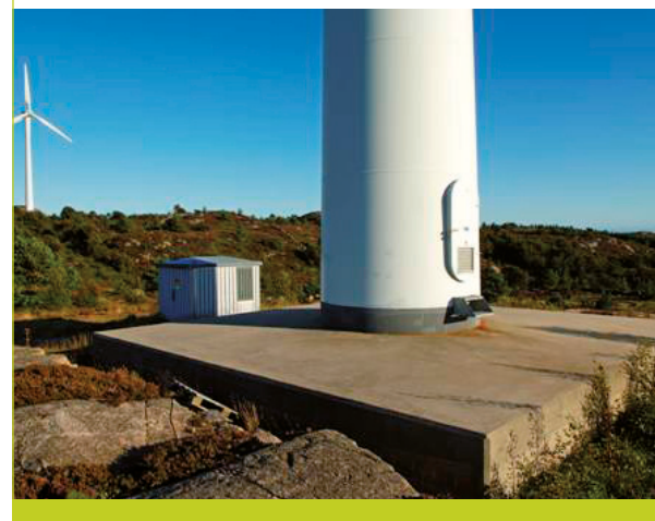
Støpt fundament for vindturbin
